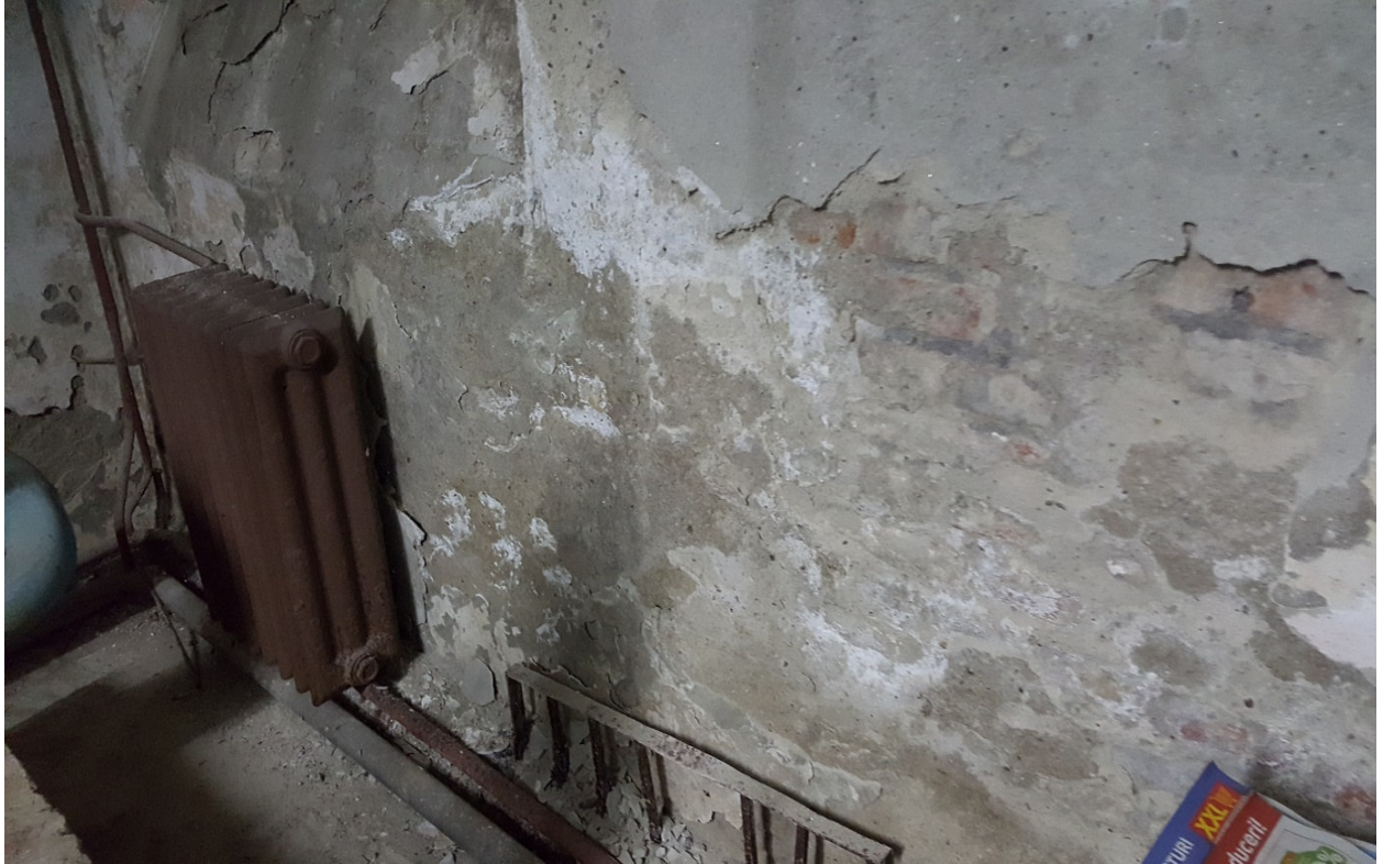
Foto 5. Instalatii termice mansarda
